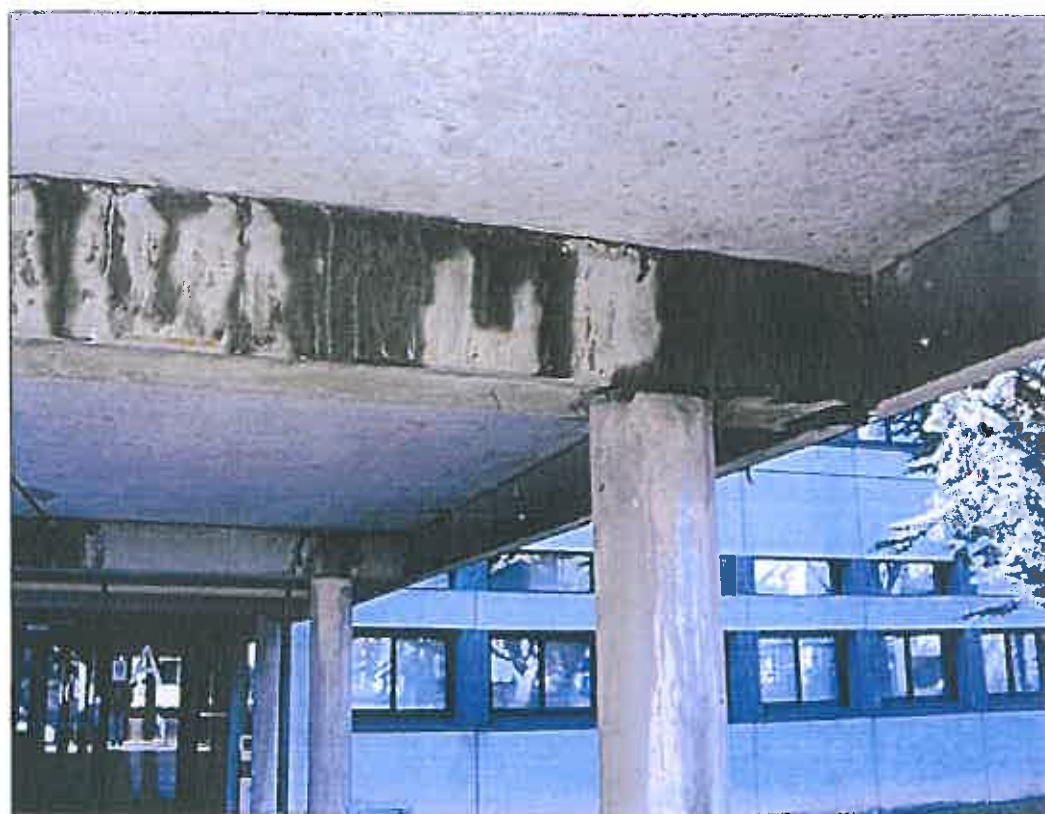
Etanchéité défectueuse.
