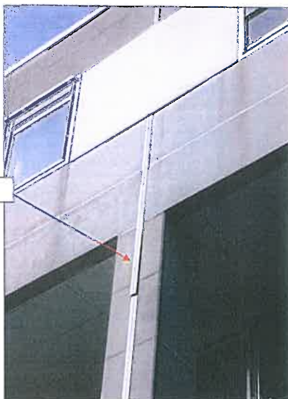
Couvre-joint mal fixé.
