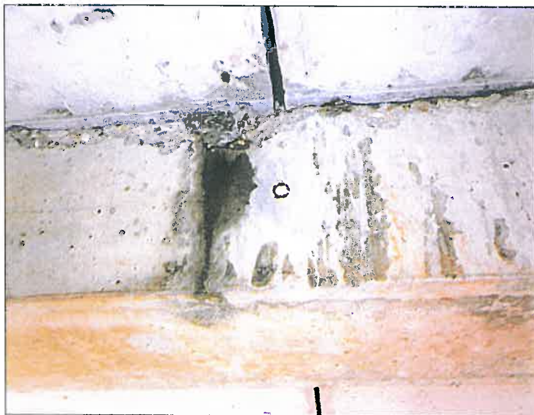
Etanchéité défectueuse.
