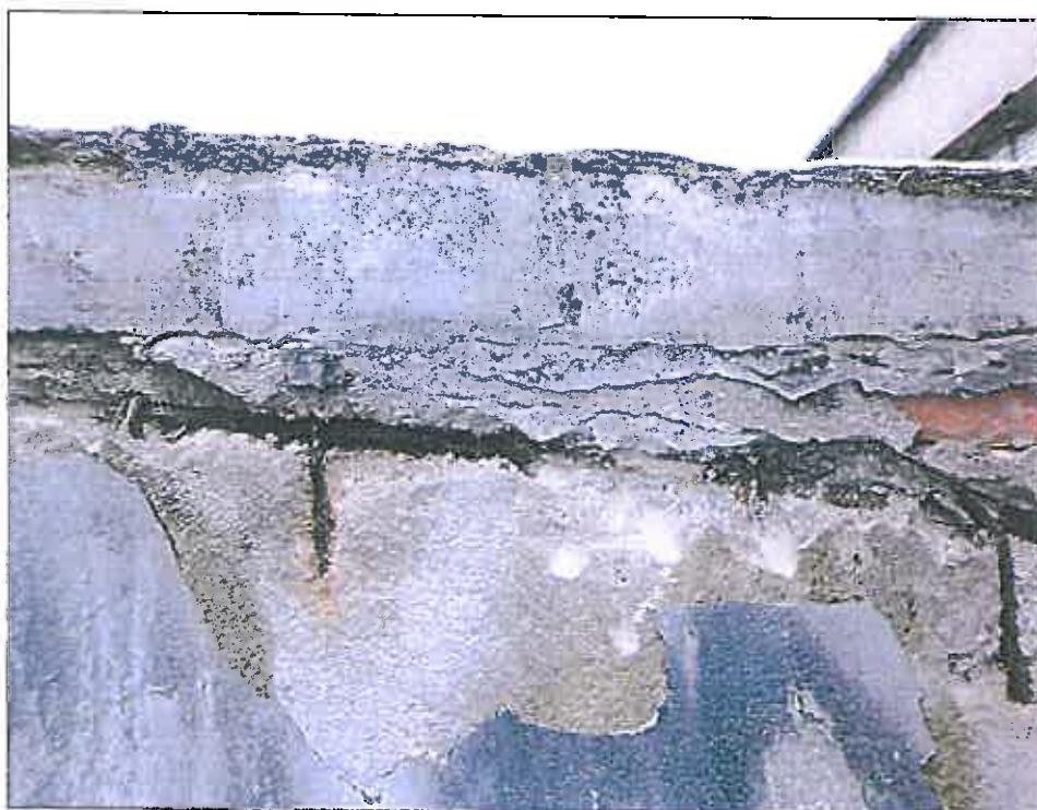
Sondage sur aciers corrodés et béton poreux.
