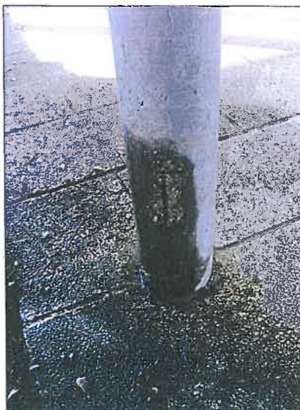
Projections d'eau de pluie sur un poteau, en partie basse.
